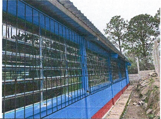
Foto 2: Finalización e Instalación de Balcones
