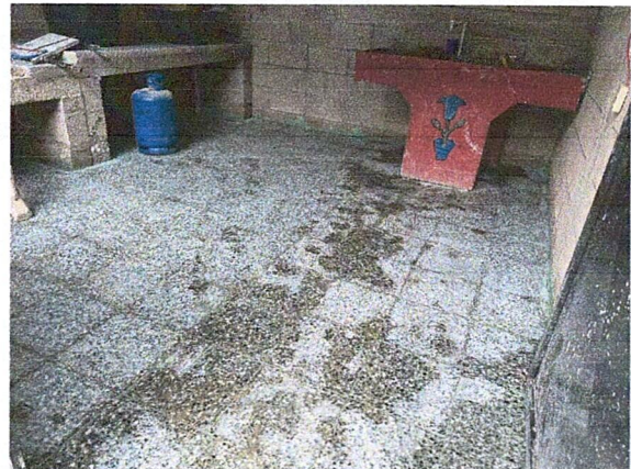
Foto 4: Finalización y sustitución de Azulejo de Granito
